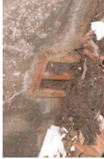
Endommagement après pénétration d'eau à travers une entrée d'air. (CSTB)
